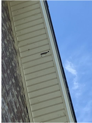
Hole in soffit.
